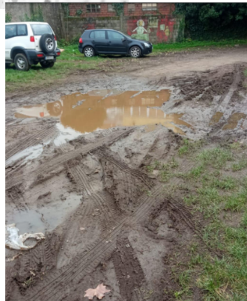
Estado do firme na zona de Muíño do Vento
